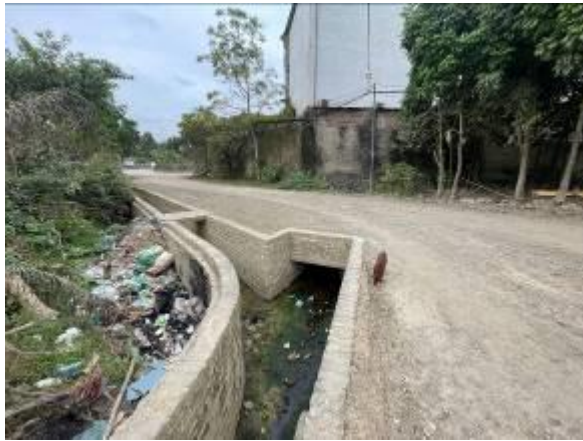
Mương thoát nước dọc đường
