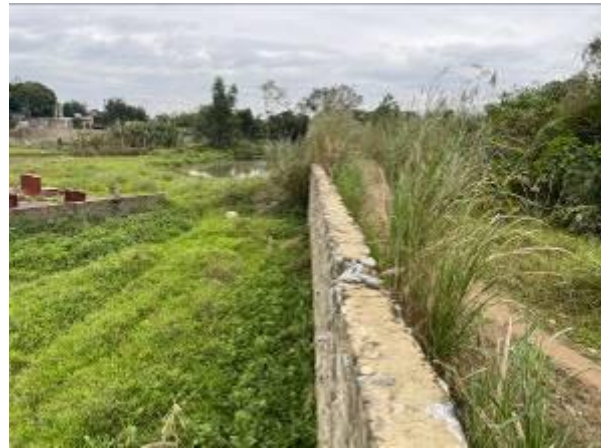
Kè đá hộ giáp dự án KDC số 11
