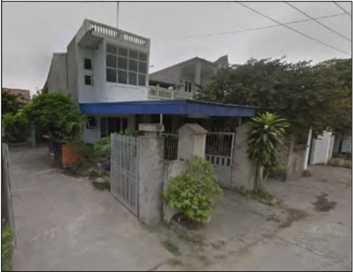
KHU NHÀ Ở HIỆN TRẠNG
